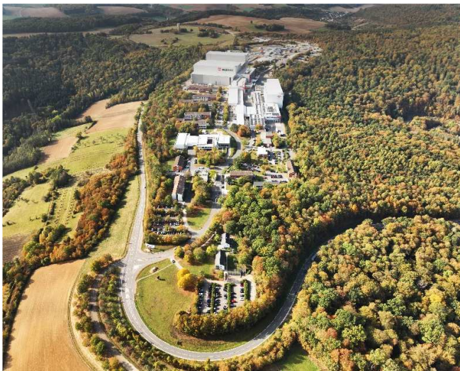
Bild 1: Luftaufnahme Industriepark Würth.jpg
